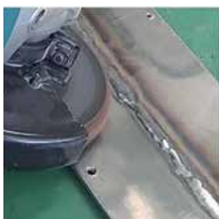
Limpieza en cordones de soldadura
