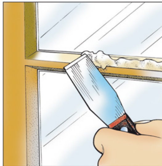
C. Alisa la masilla con una espátula para enmasillar que debes pasar en ángulo de 45° (paso 8).
