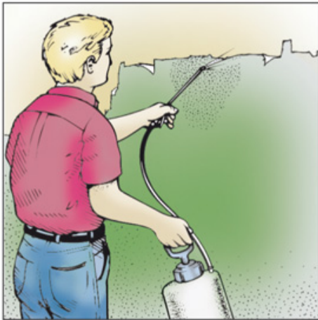
C. Aplica la solución con la ayuda de un pulverizador o de una esponja.
