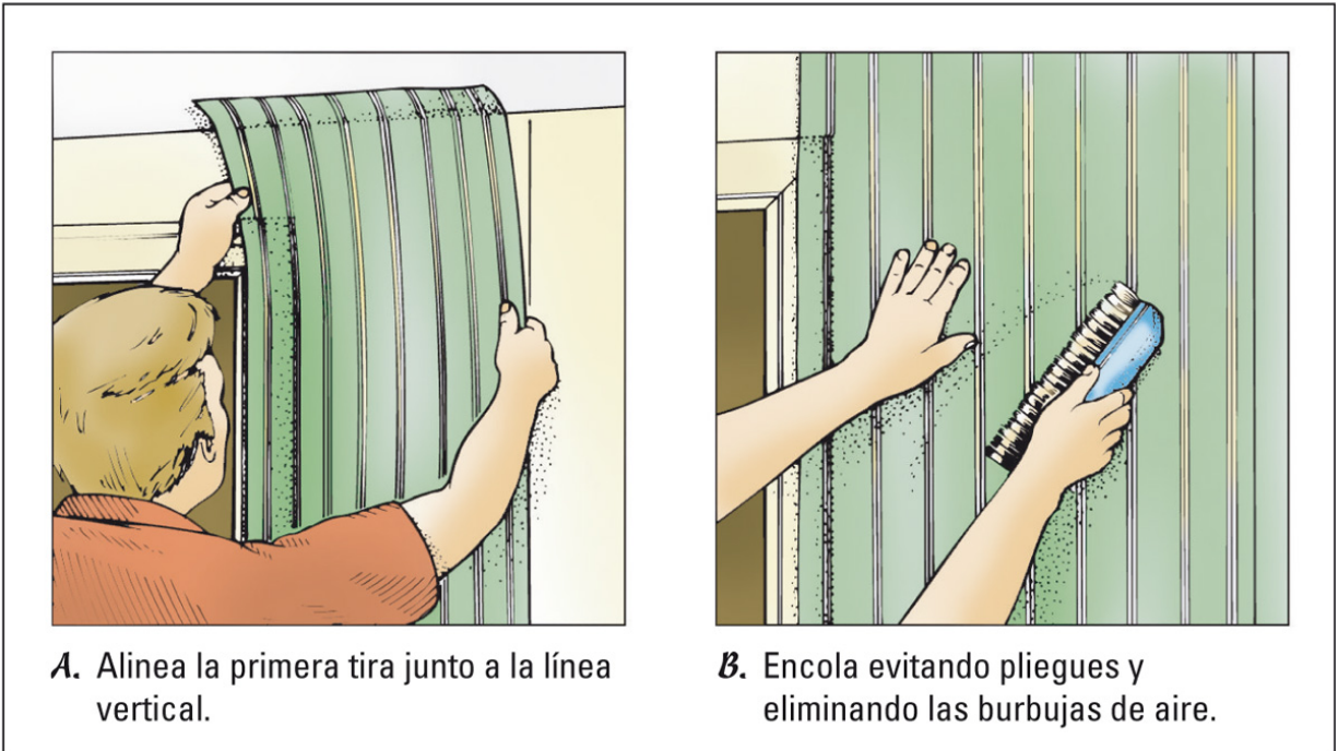
Figura 7-5: Colocación de la primera tira
