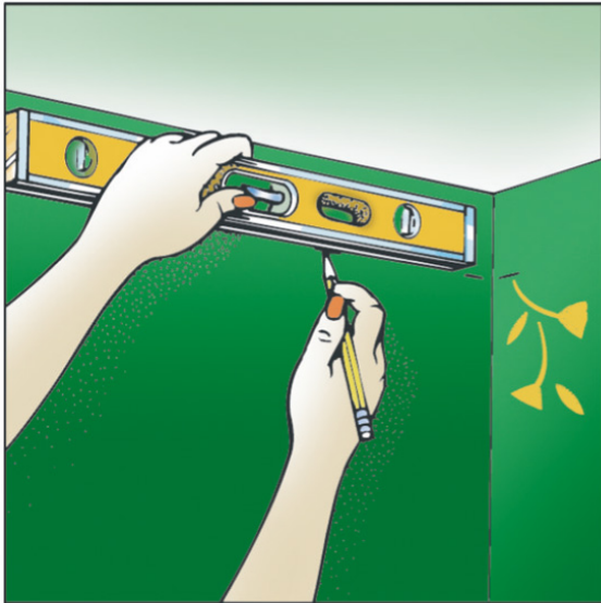
A. Trazado de una línea horizontal alrededor de toda la estancia.
