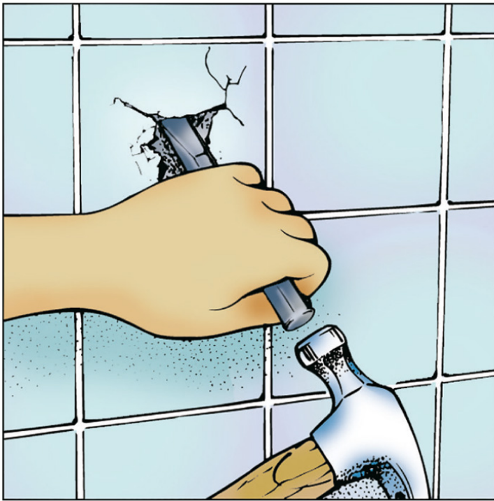
Figura 14-10: Extracción de la baldosa en pequeños trozos con el cincel
