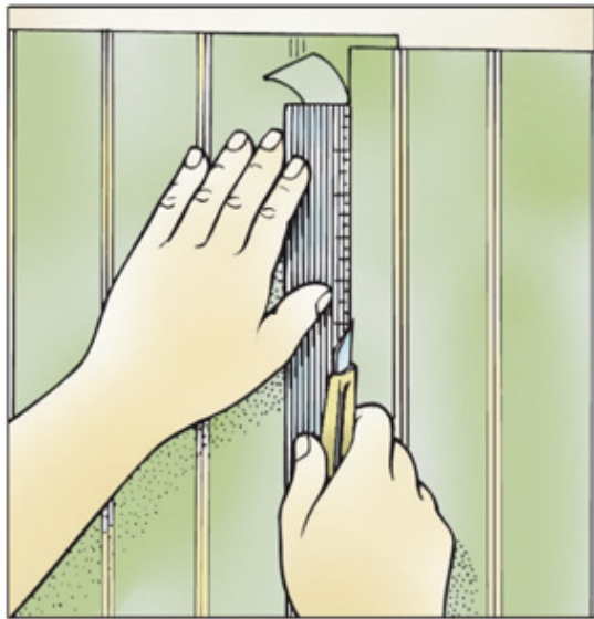
A. Recubre la primera tira y corta a través de las dos capas.
