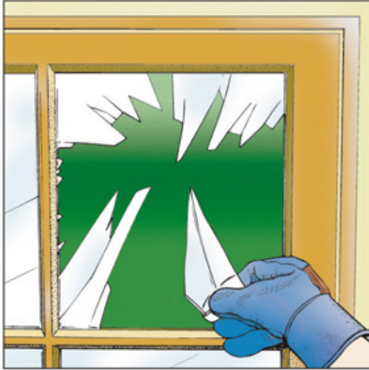
A. Ponte guantes para retirar los restos de cristal (paso 1).
